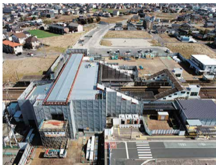
外壁工事実施中の佐和駅
